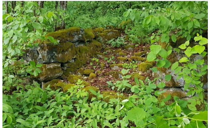
Kuva 61. Ylemmän penkereen keskellä on kivinen portaikko. Koilliseen.
