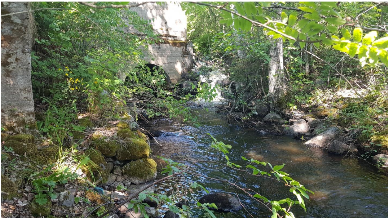
Kuva 40. Vanhoissa kartoissa näkyvä myllyjen sijaintipaikka virran alajuoksulla. Puron länsipenkereellä oli paikalla olleen sahan betonirakenteita, jonka alla oli havaittavissa kiveystä. Pohjoiseen.
