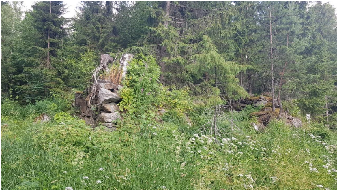
Kuva 58. Myysälän vanhan ulkorakennuksen suuri kivijalka sijaitsee Hornintien varrella, sen länsipuolella. Länteen.
