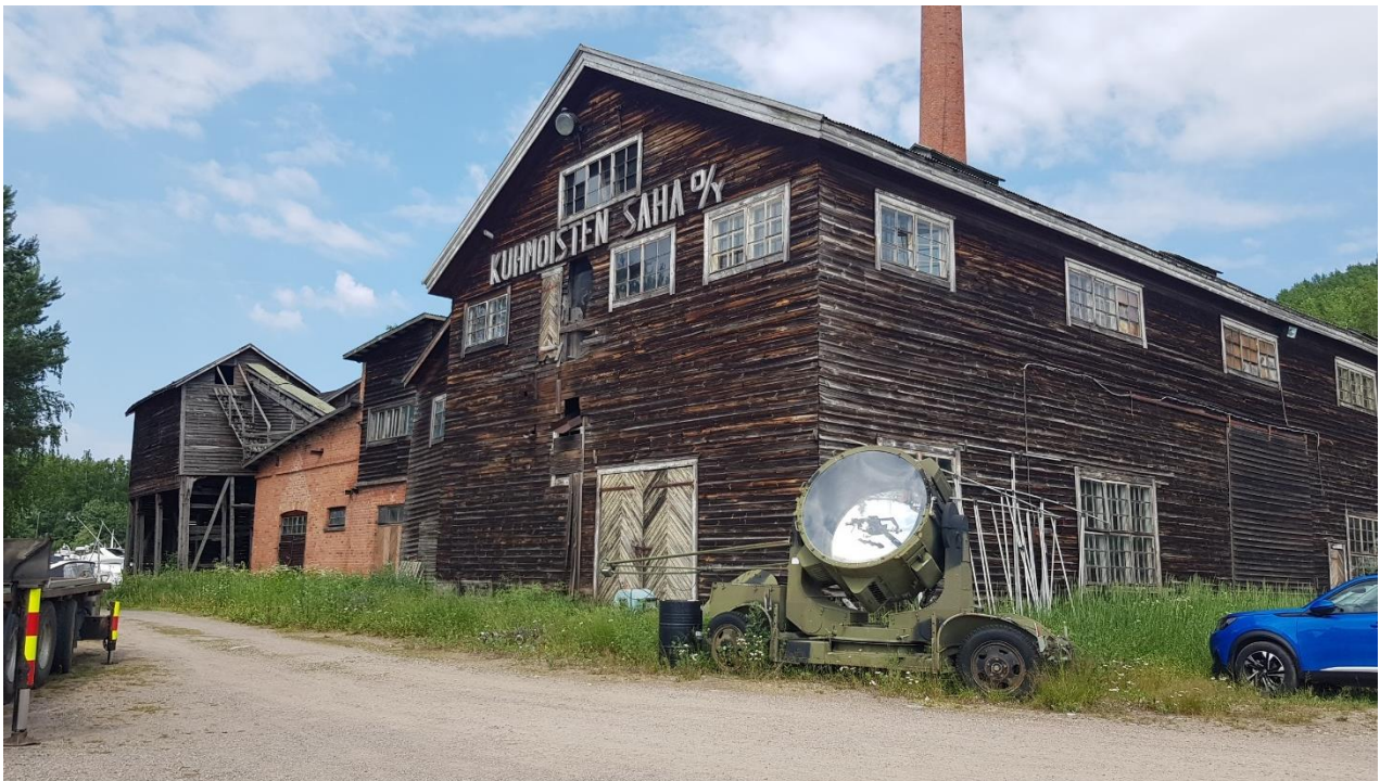
Kuva 2. Kuhmoisten sahan rakennus nykypäivän asussaan. Pohjoiseen.
