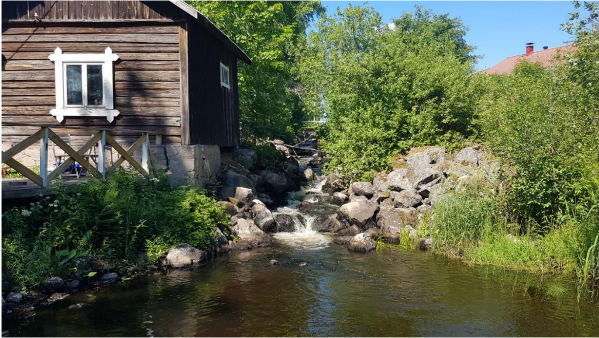
Kuva 41. Alajuoksulla sijaitseva viimeinen patoalla ja sen länsipuolella sijaitseva vanha rakennus. Pohjoiseen.
