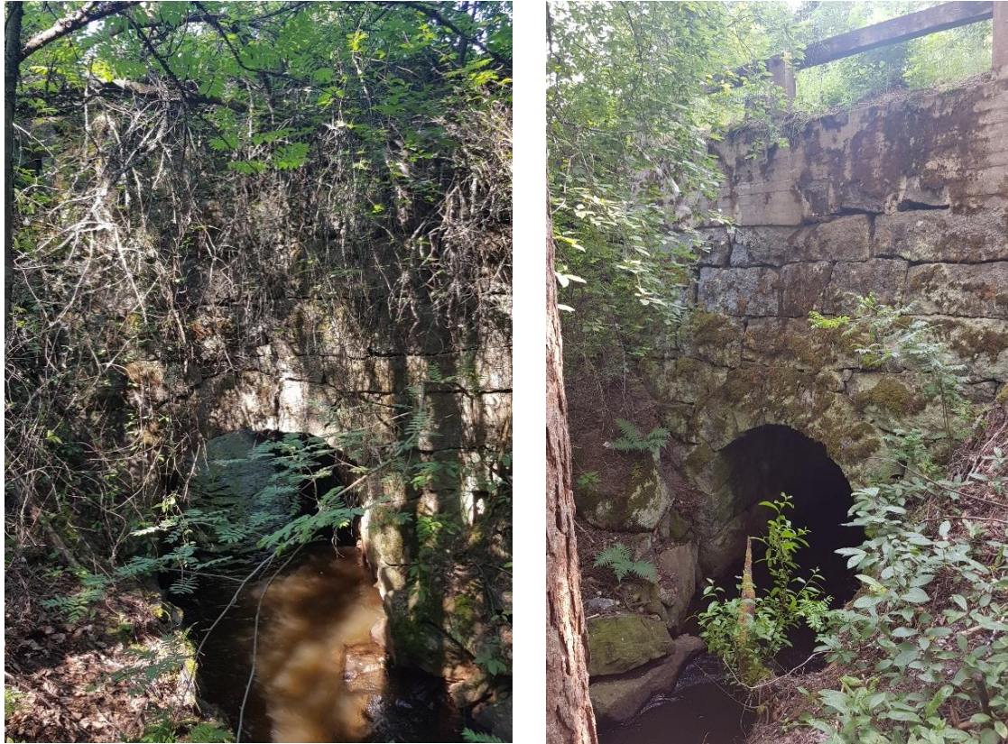
Kuva 51. Vasemmalla sillan eteläpuoli, oikealla pohjoispuoli.
