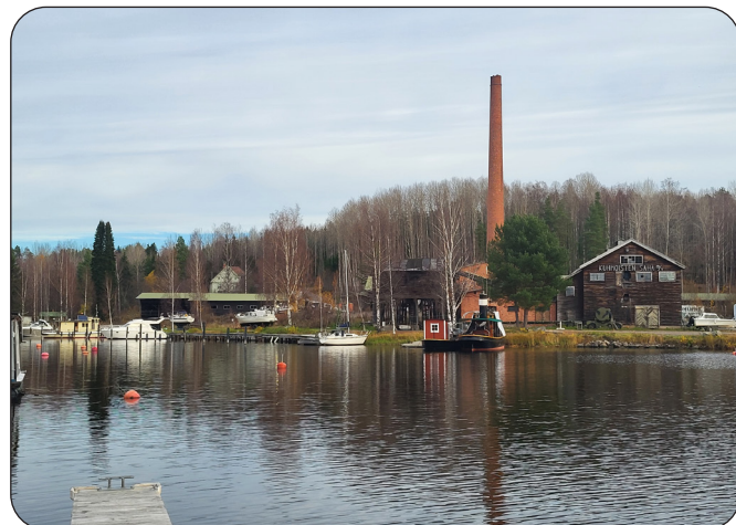
Kuhmoisten Saha rakennuksineen ovat vuosikymmenten ajan hallinneet sataman maisemaa
