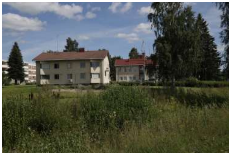
Kuva 102. Kuhmoisten kaupungintalo taustalla ja edustalla siihen liittyvä asuinkerrostalo.
