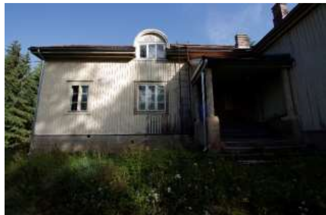
Kuvat 23 ja 24. Vasemmalla: Rakennuksen poikkipäädyssä on puolipyörän muotoinen ikkuna. Oikealla: Avokuistia reunustavat yksinkertaiset pylväät ja sen sivulla on pieni puolipyörän muotoinen frontoni.
