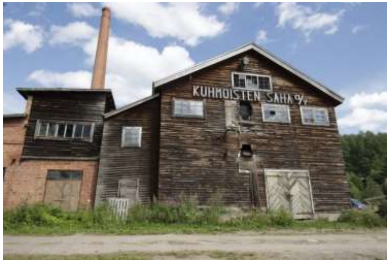
Kuva 72. Kuhmoisten sahan lounaispääty. Taustalla näkyy voima-aseman piippu.
