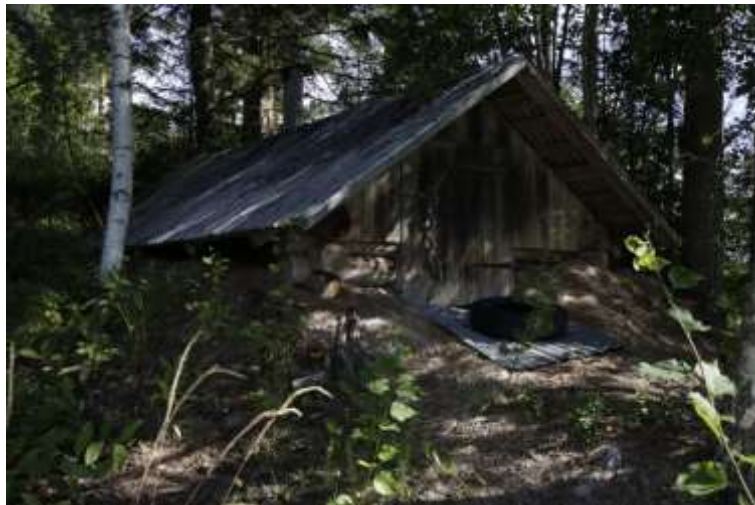
Kuva 42. Maakellari Lammintaustantien varressa.
