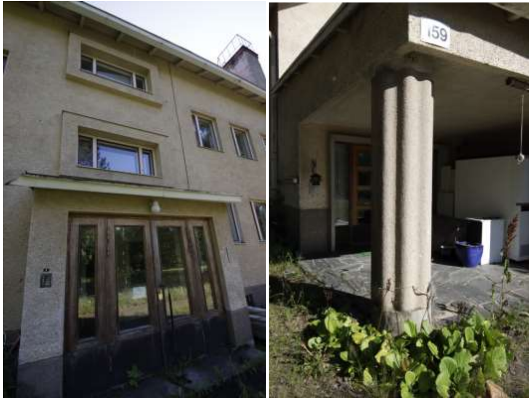
Kuva 28 ja 29. Vasemmalla: Asunto-osan pääsisäänkäynti pohjoisjulkisivulla. Oikealla: Länsipäädyn sisäänkäyntikatos.
