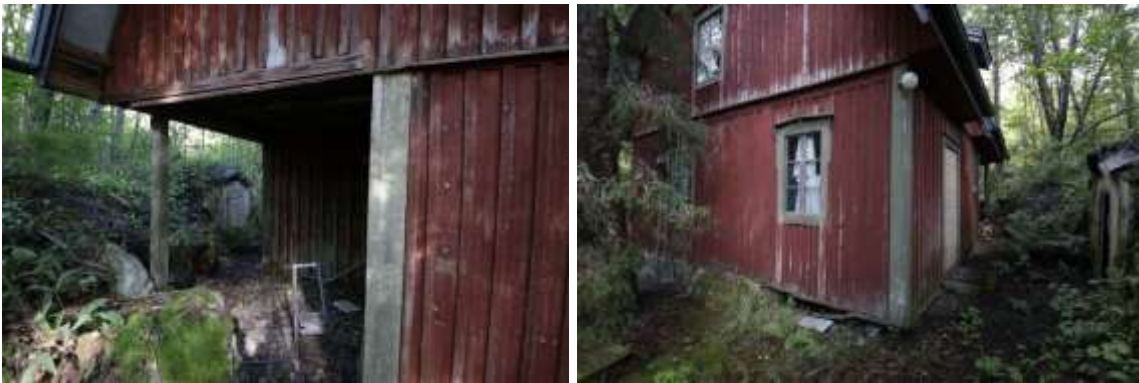
Kuva 56 ja 57. Vasemmalla: Rakennuksen luoteiskulmassa on sisäänveto, jonka perusteella rakennusmassa on ehkä alkujaan ollut L:n mallinen. Oikealla: Sisäänkäynti on pohjoisjulkisivulla ja sitä vastapäätä on maakellari. Pohjoisjulkisivulla on myös lapekattoinen frontoni.
