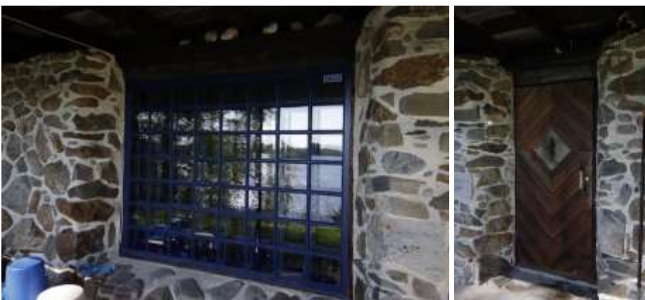
Kuva 48 ja 49. Vasemmalla: Kellarikerroksen ikkunat ovat pieniruutuisia. Oikealla: Rakennuksen ulko-ovet ovat puuvuorattuja salmiakkikuvioon.
