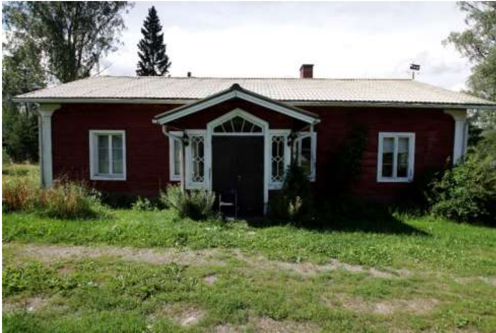
Kuva 1. Rakennuksen (tien puoleinen) pääjulkisivu. Rakennus palveli ns. muorinpytinkinä eli se ei ollut tilan varsinainen päärakennus.
