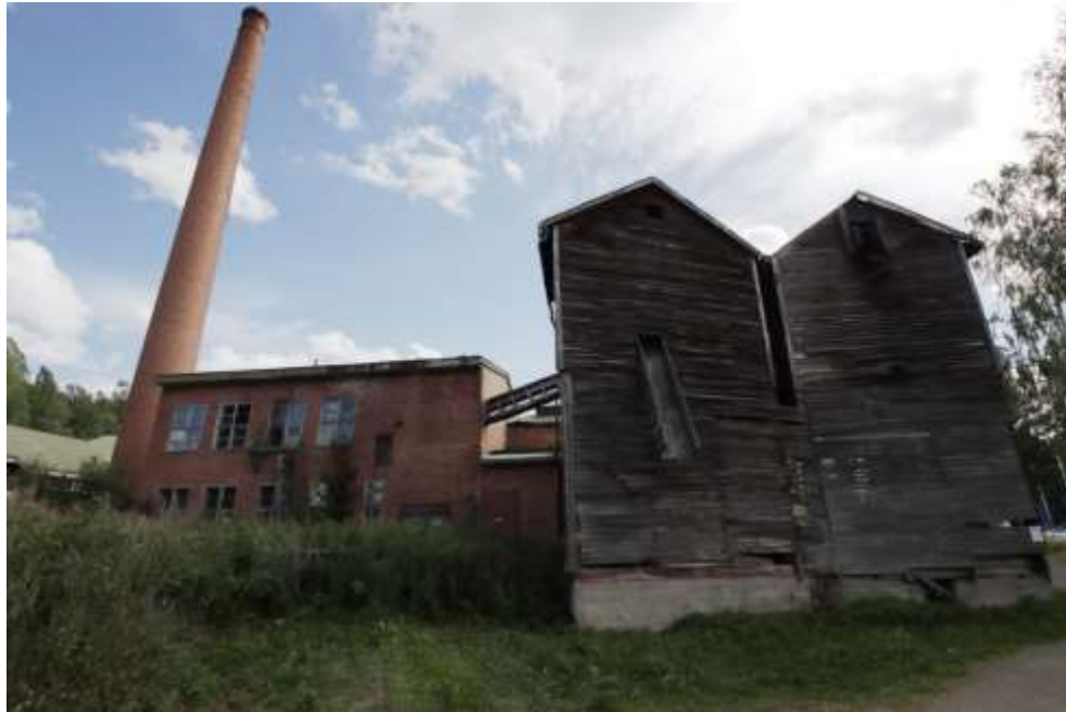
Kuva 71. Kuhmoisten sahan tiilirakenteinen voima-asema, sen savupiippu ja laitteet, joilla sahalle uitetut tukit on nostettu vedestä.
