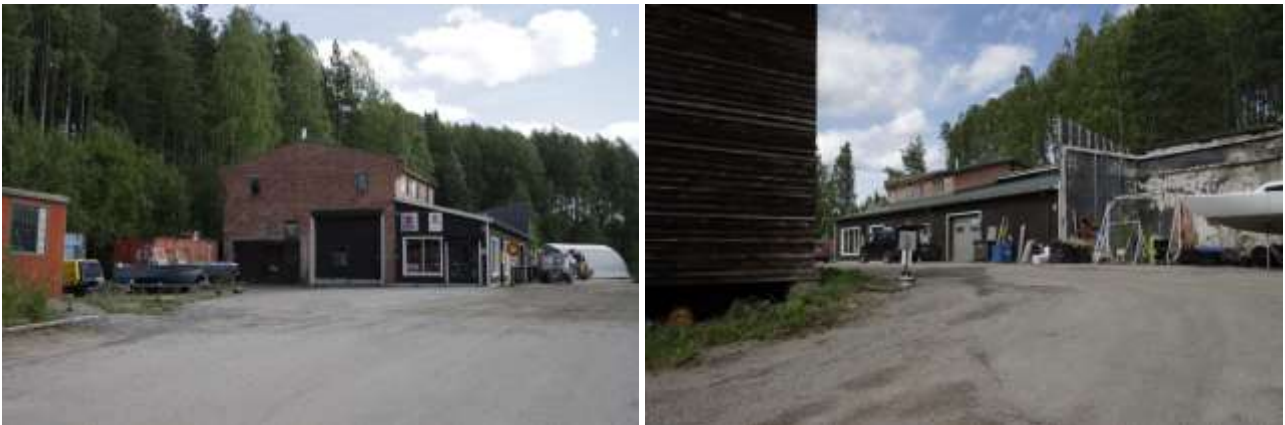
Kuva 75 ja 76. Vasemmalla: Kuhmoisten sahan kuivaamo. Sen on suunnitellut Sateko Oy Lahdesta (Matti Uimonen). Rakennus on 1950- ja 1960-lukujen taitteesta. Rakennusta on laajennettu 2010-luvulla lapekattoisella rakennusosalla. Oikealla: Kuhmoisten sahan kuivaamo. 2010-luvulla rakennuksen lounaisjulkisivun ulkoneva osa on purettu.
