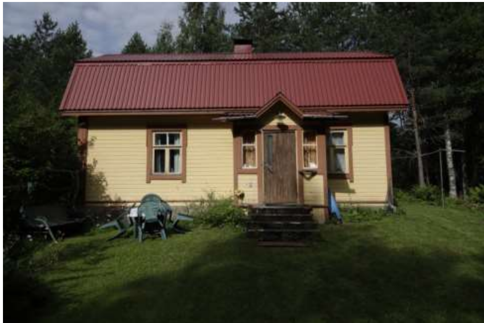
Kuva 40. Jokelan talon Poikkijärvenkadun suuntaan avautuva pääjulkisivu.
