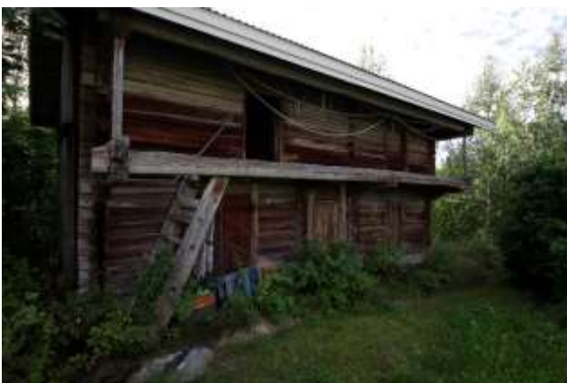
Kuva 16 ja 17. Vasemmalla: Kaksikerroksinen luhtiaitta, jonka toinen kerros on erilaisten salvosten perusteella rakennettu maantasokerroksen päälle myöhemmin. Luhtiaitta sijoittuu pihapiirin itäreunalle. Oikealla: Hirsirakenteinen syytinkirakennus sijoittuu asuinrakennusta vastapäätä. Luhtiaitta sijaitsee sen koillispuolella.
