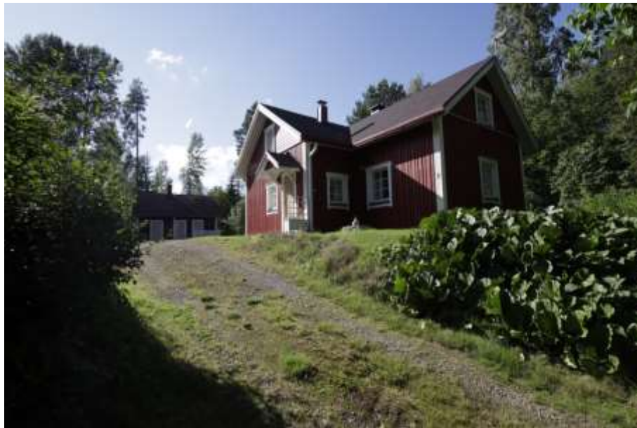
Kuva 60: Punalantien asuinrakennuksen pääjulkisivu.
