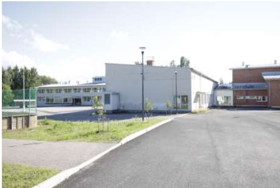
Kuva 65. Vuosina 1960 ja 1962-63 sekä 1990 peruskorjattu entinen yhteiskoulu, joka on tyhjillään sisäilmaongelman vuoksi. Kuvan oikeassa reunassa näkyy vuodelta 1998 oleva liikuntahalli, joka on edelleen käytössä.
