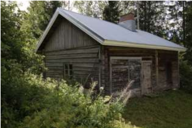
Kuva 18. Navetan itäpuolella pihapiirin etelälaidalla oleva hirsirakenteinen sauna.
