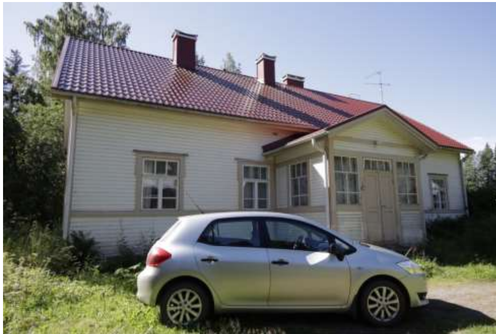
Kuva 37. Asilammen asuinrakennuksen länsipääty ja pohjoisjulkisivu.
