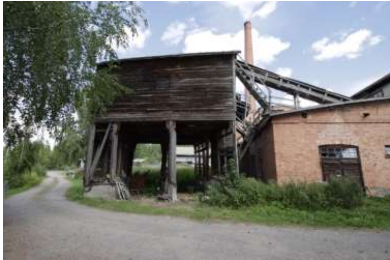
Kuva 74. Sahan voima-aseman kupeessa on kaksi tornimaista rakennusta, jotka luultavasti ovat liittyneet sahalle uitettujen tukkien nostamiseen vedestä. Torneista johtaa kuljettimet voima-asemalle.
