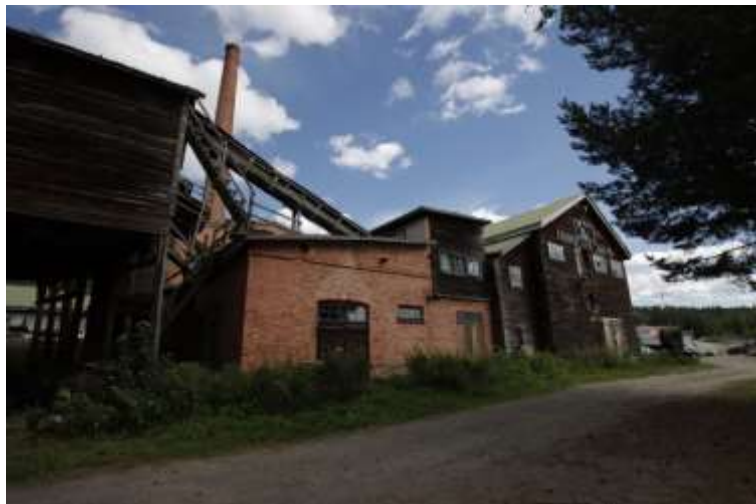
Kuva 73. Kuhmoisten sahan voima-aseman lounaispääty.
