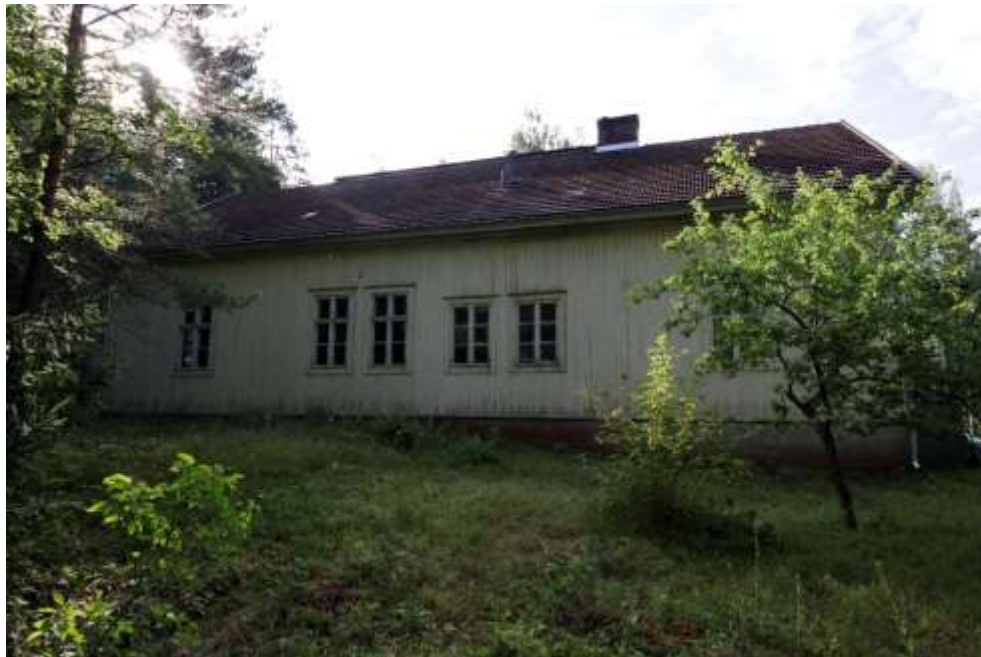
Kuva 20. Poikkijärven koulun Tampereentien puoleinen julkisivu.
