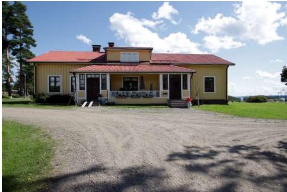
Kuva 4. Tikan tilan päärakennuksen pääjulkisivu.
