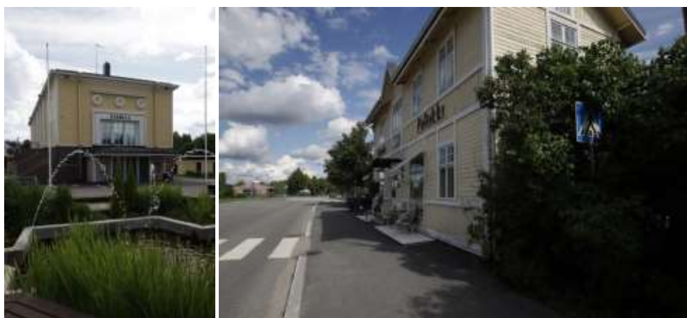
Kuva 103 ja 104. Vasemmalla: Kuhmola. Oikealla: Heinon talo.
