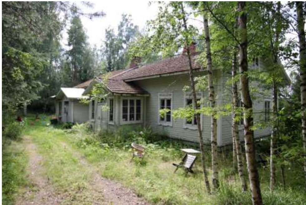
Kuva 9. Mäkelän talon pääjulkisivu.
