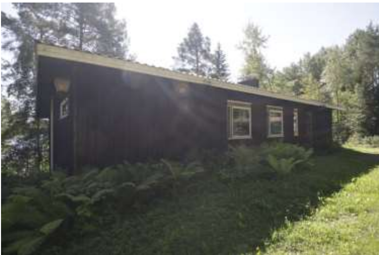
Kuva 47. Ylärinteen puoleinen luoteisjulkisivu, jossa on pääsisääntie.
