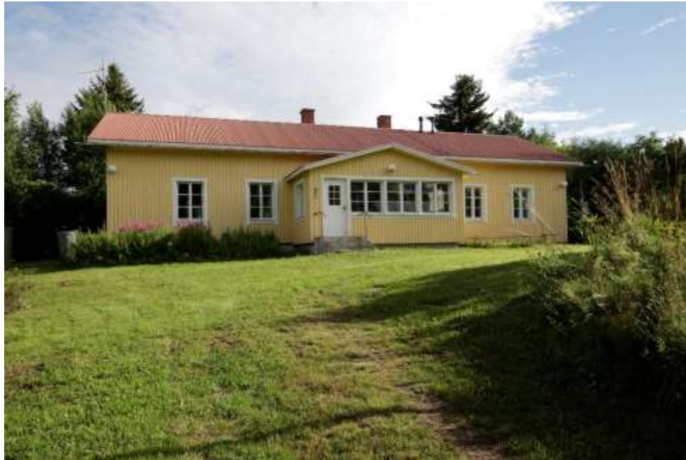
Kuva 17. Vuorikon tilan päärakennuksen pääjulkisivu.
